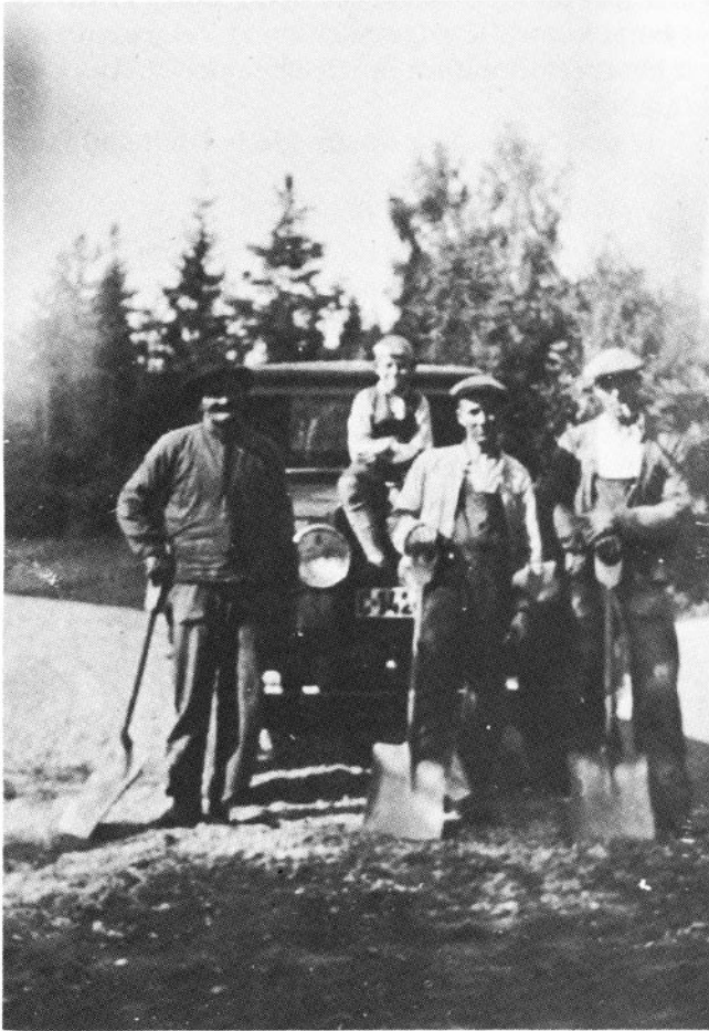
I 1930 ble Vestveien påbegynt fra Fjellstrand. Arbeidet ble utført som "nødsarbeid". Første etappe fram til Ommenveien var ferdig i 1932. På bildet; veioppsynsmann Mathisen, Eugen og Kristian Persilengen. (Odd Persilengen på bilens panser).
