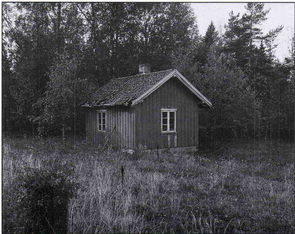
Det gamle bryggerhuset
