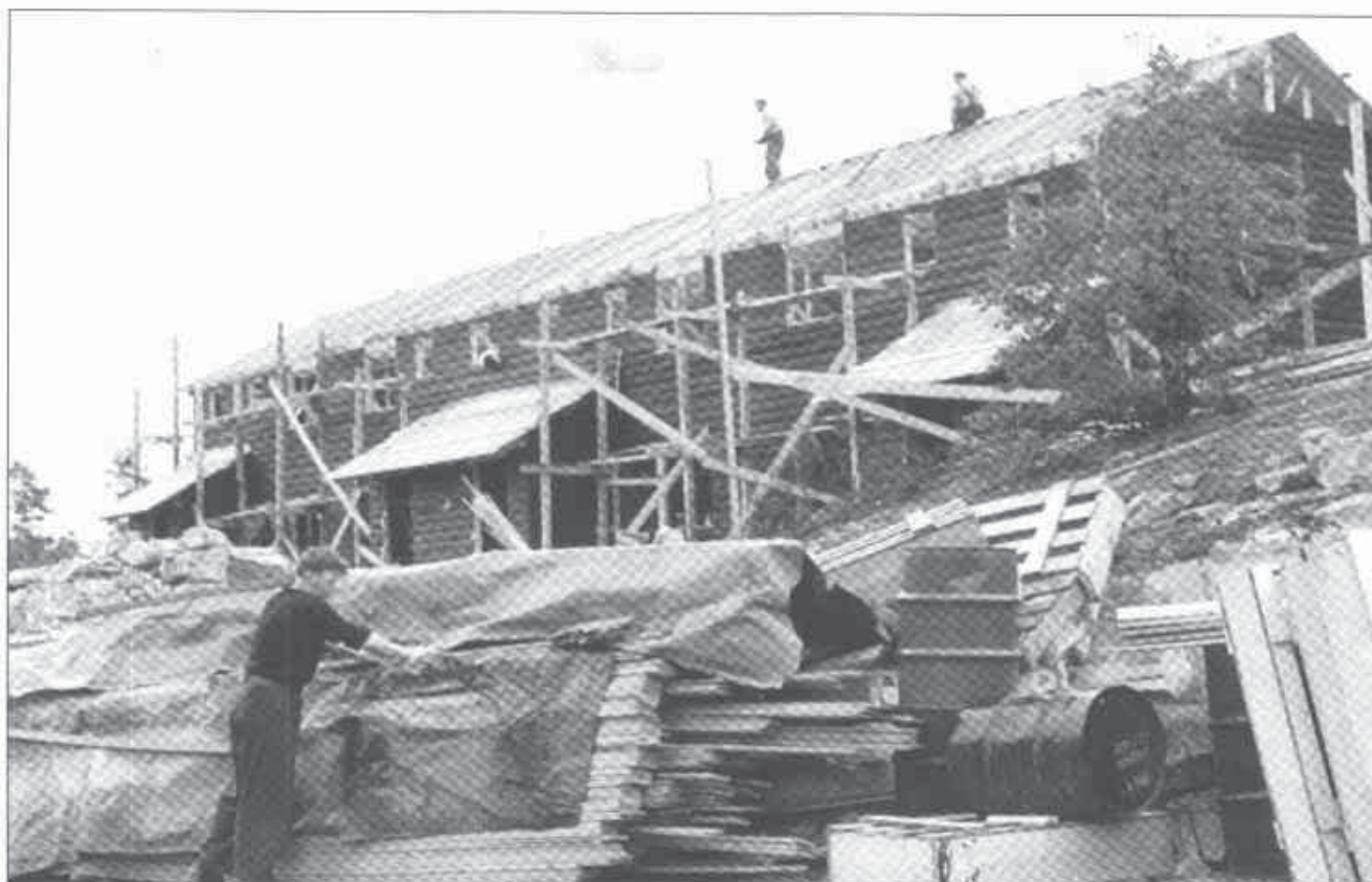
Fra oppførelsen av borettslaget Tangen I i 1953.
