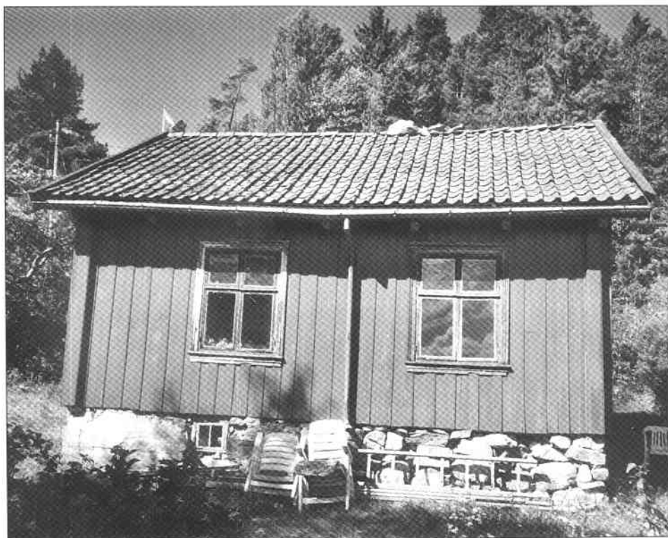
Huset sett fra øst.
