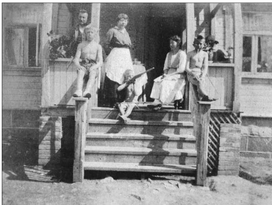
Familien på trammen utenfor huset deres «Hauge» på Fjellstrand. Gitt av Jon Scott Karlsen.
