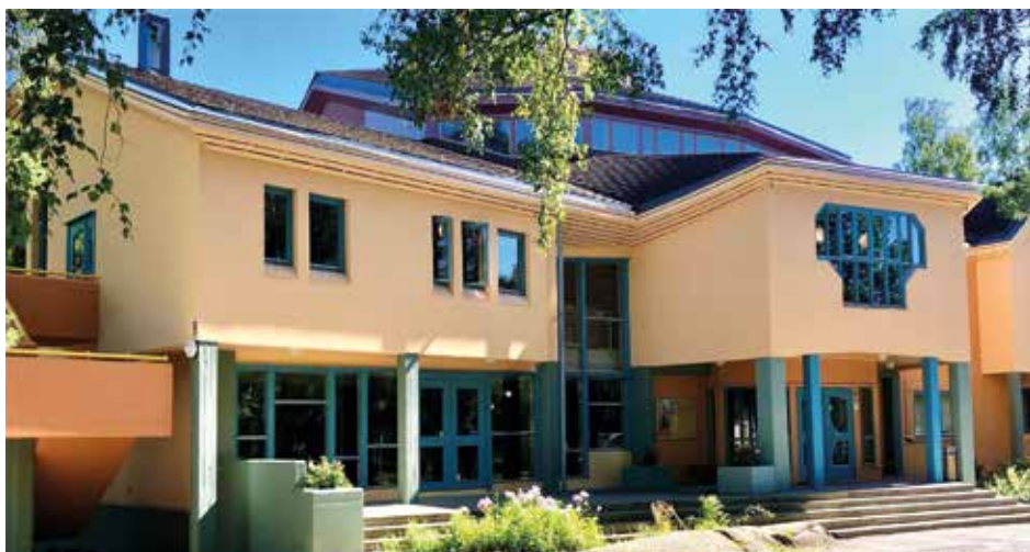
Fasaden på vestsiden med vinkler og nye farger.
